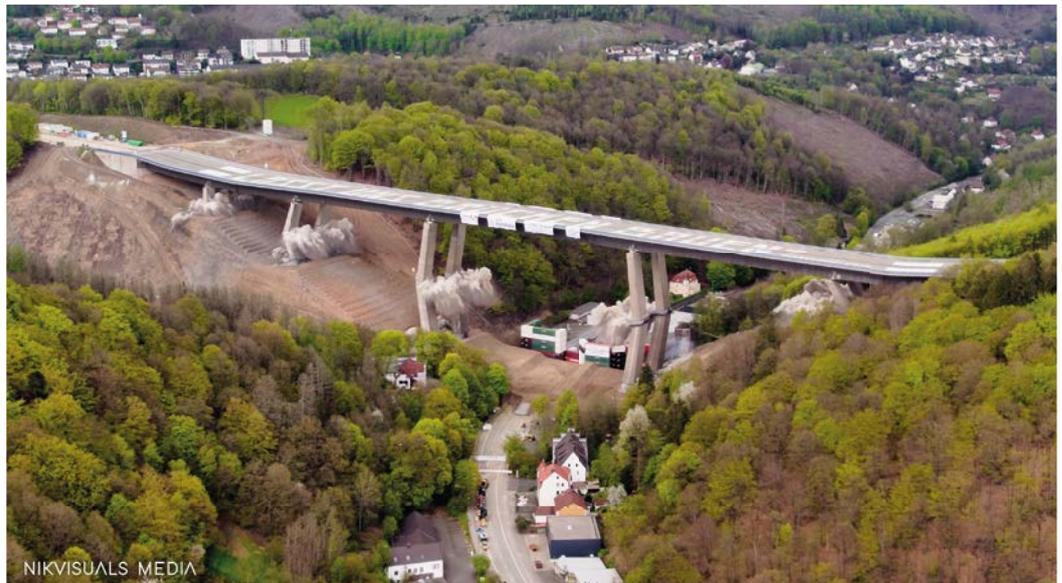
Der marode Koloss, mit einer Länge von 450 Metern, einer Höhe von 70 Metern und mit 17.000 Tonnen Gewicht wurde am 07.05.2023 mit 150 Kilogramm Sprengstoff zum Einsturz gebracht.
